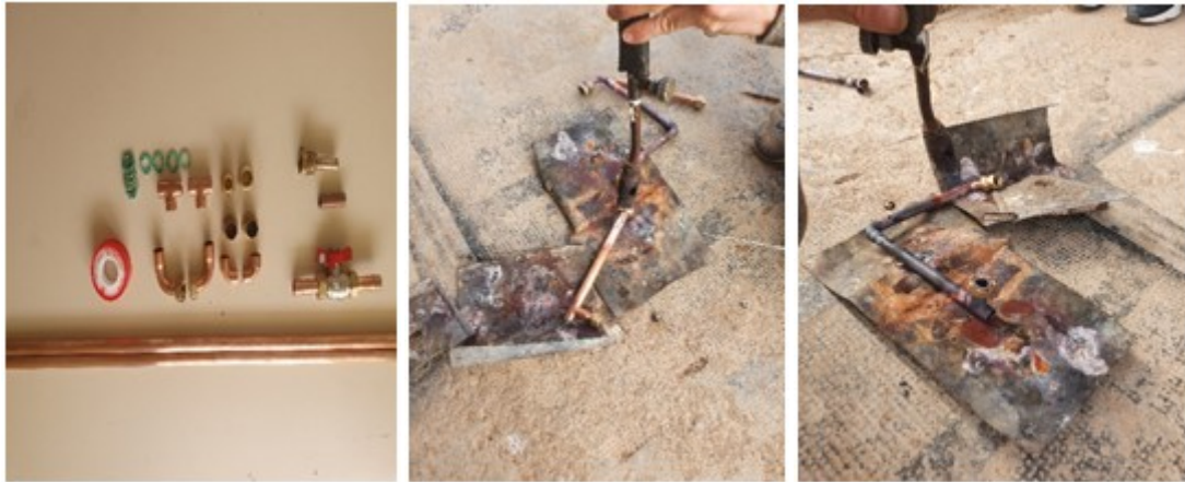
Figure 3.3 Soudage des tubes en cuivre.
