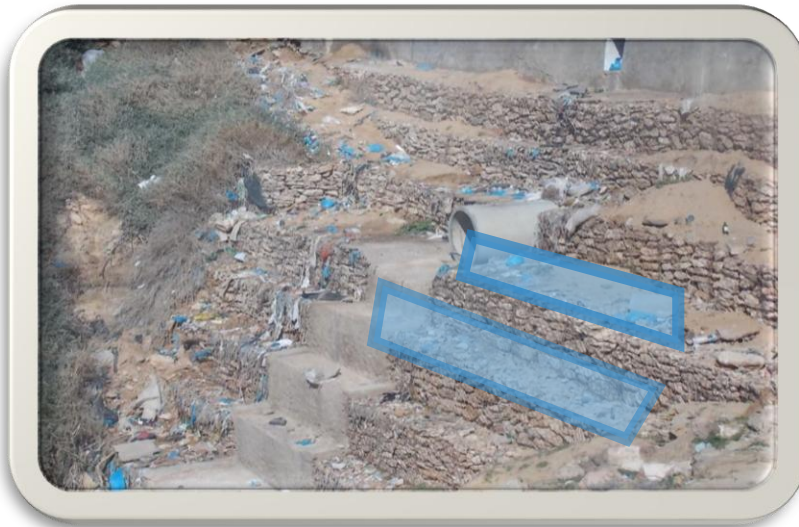
Figure 42: Les eaux usées sont rejetées dans un caniveau à ciel ouvert juste de se déversé dans la mer.
