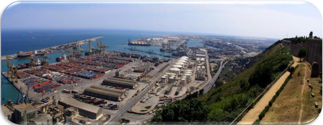
FIGURE 28: VUE ETONNANTE SUR LE PORT A CONTAINERS DE BARCELONE, DEUX ASPECTS DE LA VILLE TRES DIFFERENT. SOURCE : 2011
