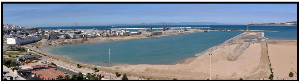
FIGURE 69: VUE SUR LES TRAVAUX DE CONSTRUCTION DU NOUVEAU PORT DE PLAISANCE
