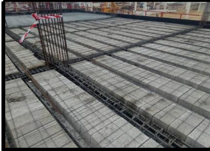
Figure I.5 : Plancher en corps creux
