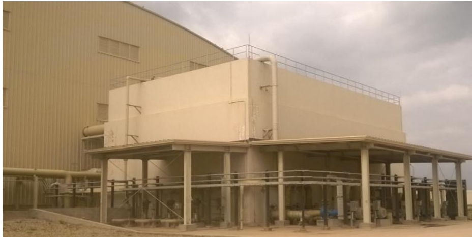
Figure 46: Réservoir de l'eau dessalée.
