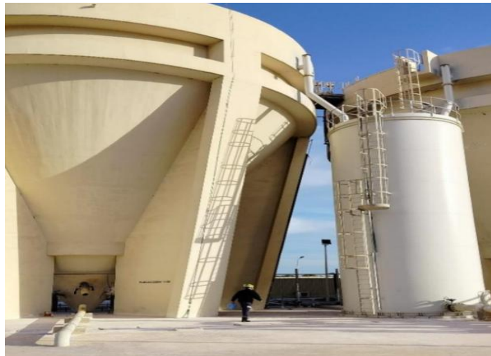
Figure 48: Bac de stockage du lait de chaux.
