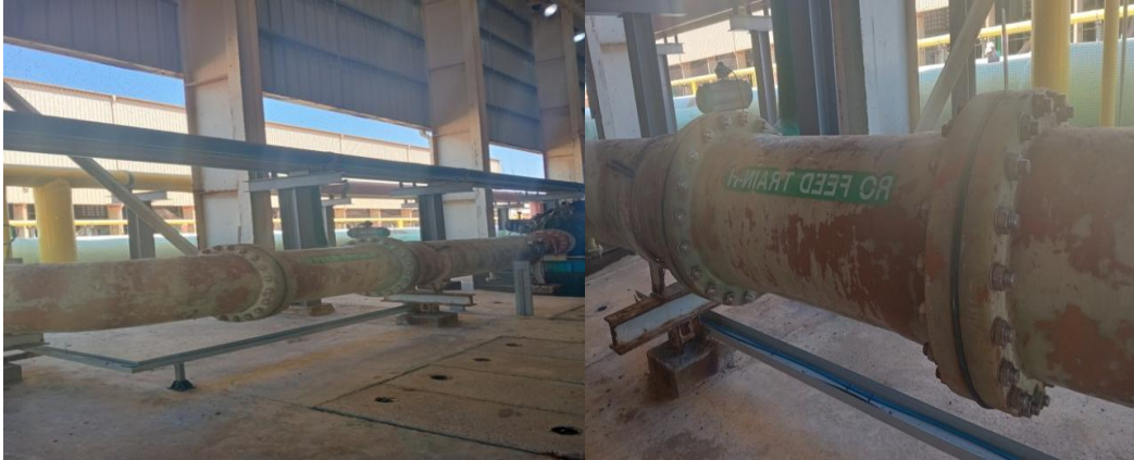
Figure 39 : Ligne d'alimentation du système d'osmose inverse (RO Feed).
