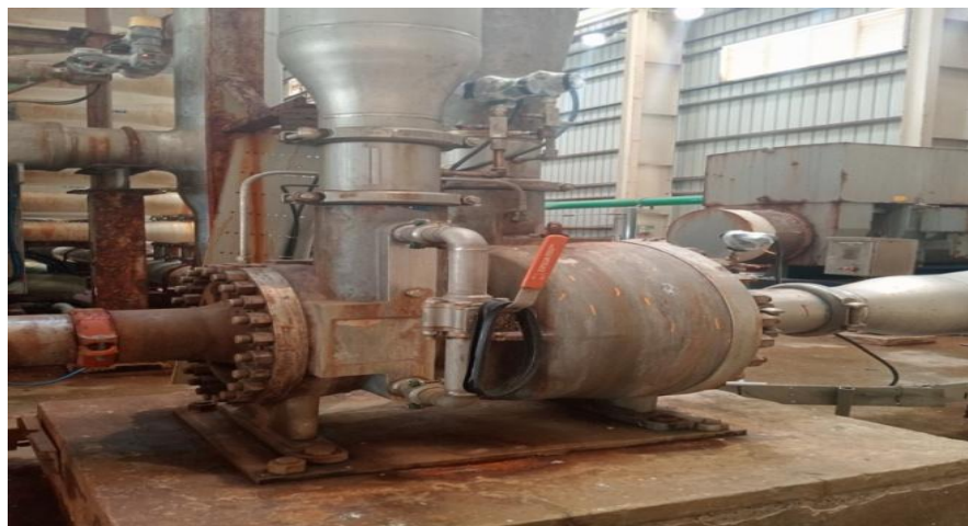
Figure 42: turbo chargeur pour récupérer l'énergie du rejet d'osmose inverse.
