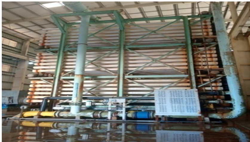
Figure 44 : train d'osmose inverse.
