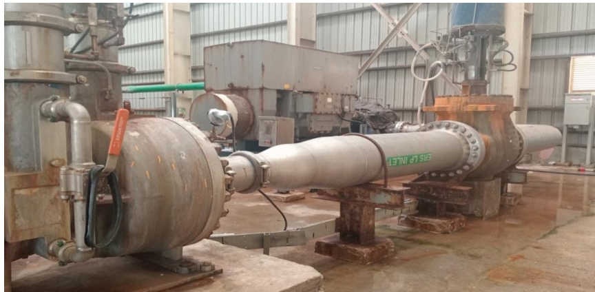
Figure 42: turbo chargeur pour récupérer l'énergie du rejet d'osmose inverse.
