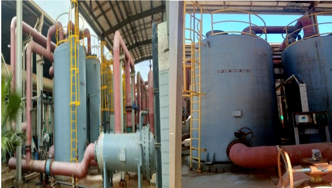
Figure 35 : système de nettoyage-en-place (CIP) de l'UF.
