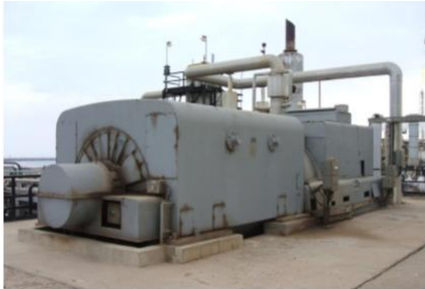
Figure 1.7 : Le Turbo-alternateur.
