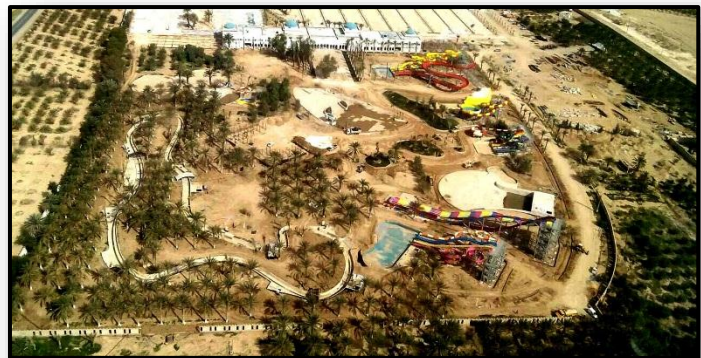
Figure 72 : Le début des travaux en 2012
