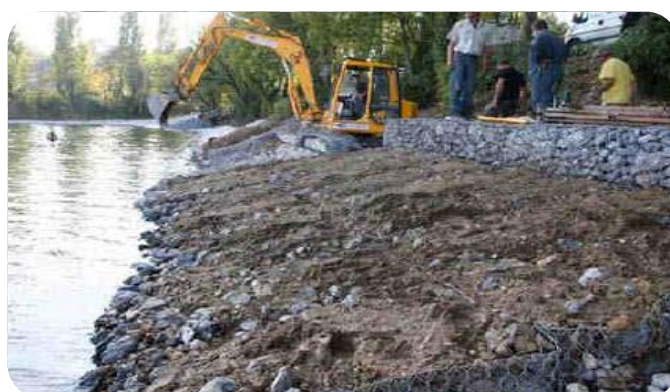
Début des travaux
