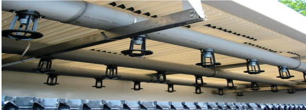
Figure I-5 : Système de dispersion de fluide à refroidir.
