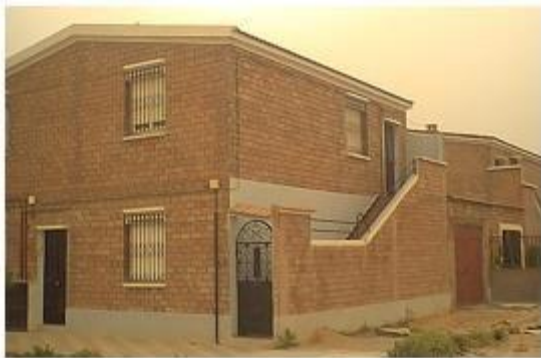
Figure I.8 : Logements collectifs R+1 à Sidi Bel Abbès (Algérie), (Guettala, 2003) [12]
