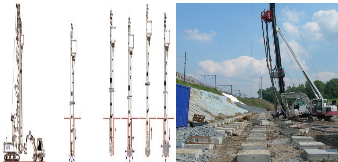
Figure I.1.1. Exemple de réalisation d'inclusion rigide in situ. Réalisation de 2 lignes ferroviaires, Bruxelles 2010 [1].
