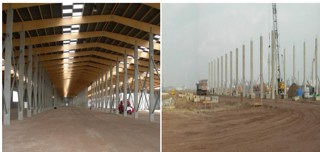
Figure I.1.7. Pieux battus en béton préfabriqués. Hangars pour stockage, Belgique 2006 [3].
