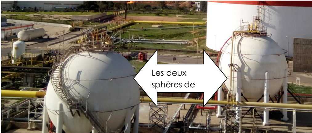
Figure I.4 : le stockage tampon de la charge GPL.
