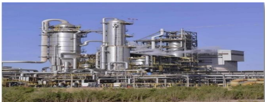
Figure I.5 : Unité de production d'ammoniac
