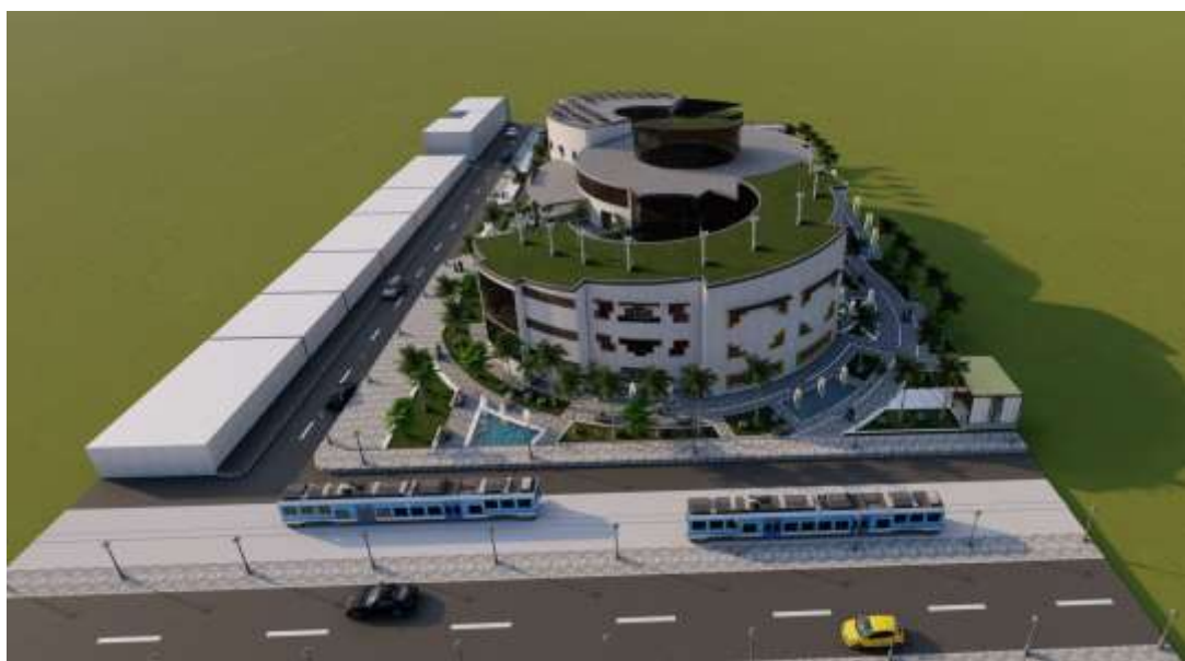
Figure 80 : vue du projet(source : Auteurs)
