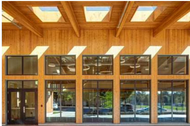
Figure25 : Les fenêtres à double ouverture (Source : Bora)
