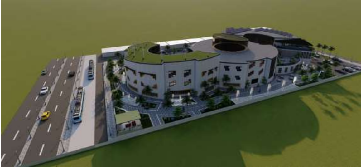
Figure 81 : vue du projet(source : Auteurs)
