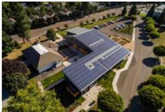
Figure23 : Le réseau photovoltaïque sur le toit (Source :Bora)
