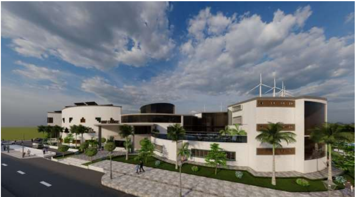
Figure 87 : vue du projet (source : Auteurs)
