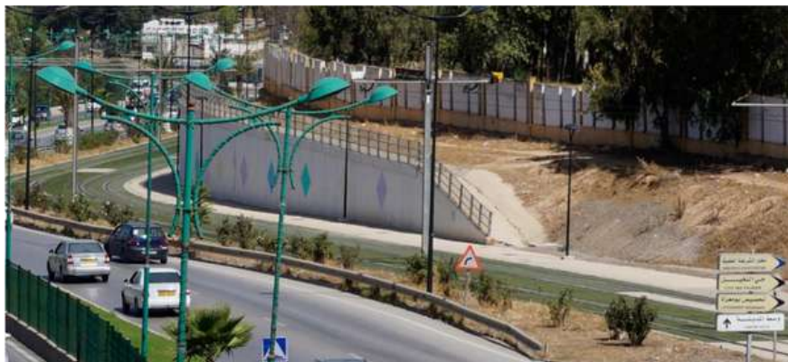
Tapis de Gazon artificiel sur la plateforme de la ligne du tramway
