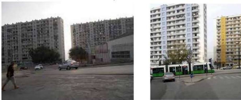
La Réhabilitation des façades de la cité Ciloc entre 2009 – 2020
