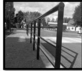
Figure N°7 : barrière en métal
