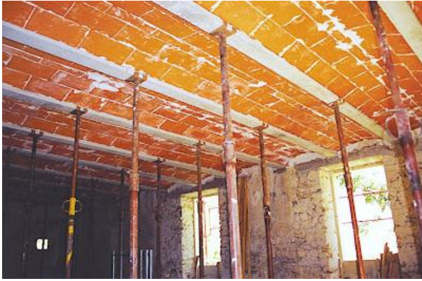
Figure 55 : courage d'une dalle en voutain
