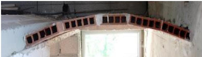
Figure 54 : système constructif d'une dalle en voutain
