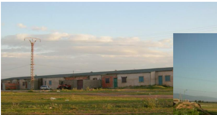
Figure 33 : Bande de logements
