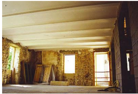
Figure 56 : étapes finale de construction
