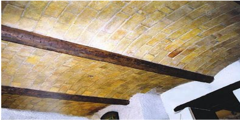
Figure 52 : Plancher ancien à solives bois et voûtains en briques pleines
