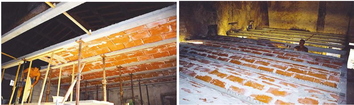
Figure 53 : étapes de construction d'une dalle en voutain
