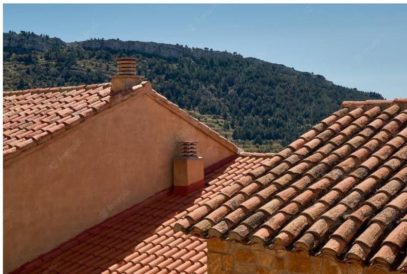
Figure 48 : toiture en tuile
