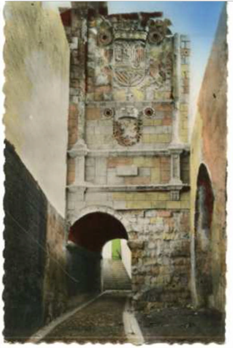
Figure n°34 : Carte postale de 1929. Par rapport à la photo de droite, on remarque dans les deux rectangles inférieurs qu'il y a eu restauration, mais avec des blocs plats.
