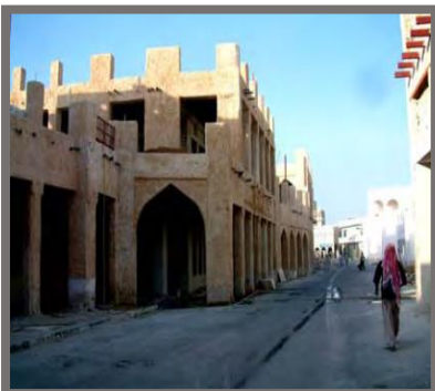
Figure 84: le souk avant la réhabilitation. Source : idem.
