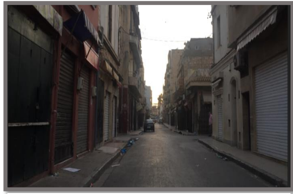
Figure 106: Quelques Façades commerciales récentes. Source: Auteurs.
