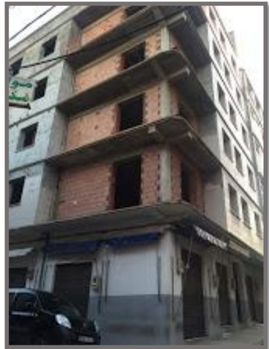
Figure 50 : Nouvelle construction non achevée (système poteau poutre en BA). Source : auteurs.
