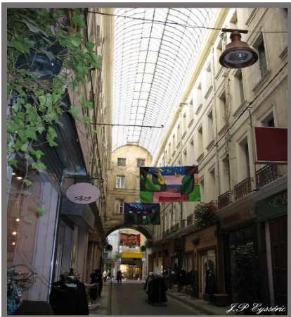
Figure 15 : rue commerçante vitrée située au Vaucluse, région Provence-Alpes-Côte d'Azur. Source : http://1dedou84.centerblog.ne
