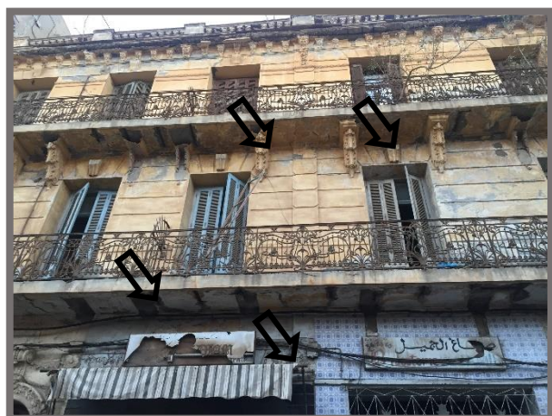
Figure 95: Les éléments de façade ont restaurés sur un immeuble de rapport colonial. Source: Auteurs.
