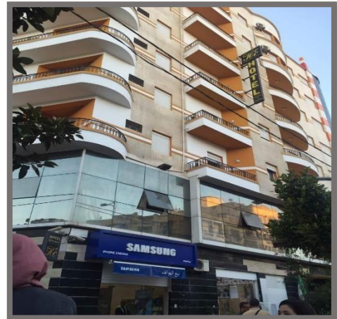
Figure 47: un hôtel nouvellement construit sur la rive droite du boulevard Zabana. Source: auteurs
