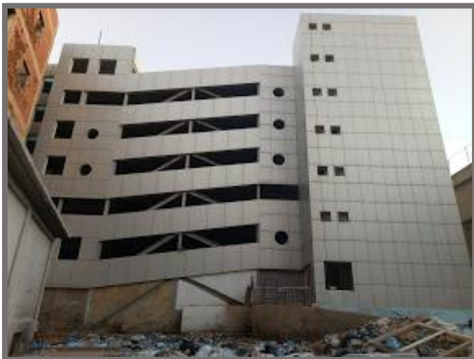
Figure 51 : parking de style high-tech récemment édifié (charpente métallique). Source : auteurs
