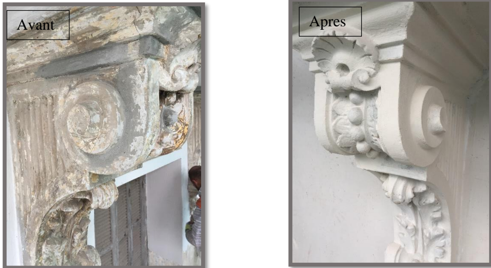
Figure 96: exemple de restauration de modillon sur un immeuble colonial (centre-ville de Mostaganem). Source : Auteurs.
