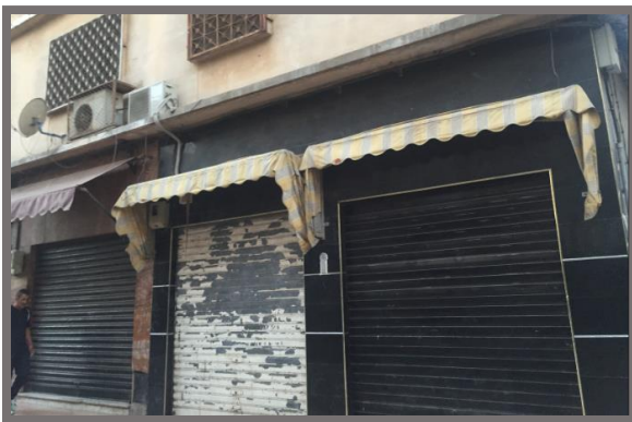
Figure 104: façade commerciale ancienne. Source : Auteurs.
