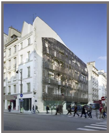
Figure 69: les logements sociaux construits par les architectes Chartier-Corbasson à l'angle des rues de Turenne et Saint Antoine (4e), avec leur audacieuse façade évolutive et mobile, en alignement de rue.
