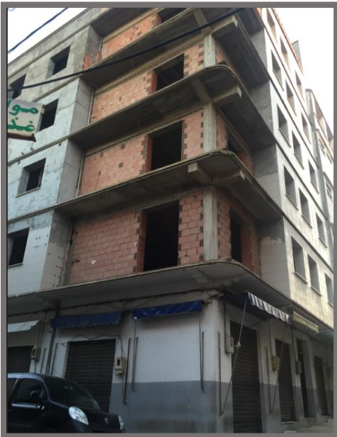
Figure 101:Façade en cours de construction sur l'axe étudié. Source: Auteurs.
