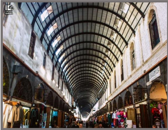
Figure 60: réhabilitation des façades et remplacement du toit source : dimashqilens.com
