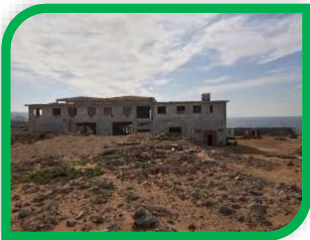
Figure 34: cadre non bâti (zone industrielle)
