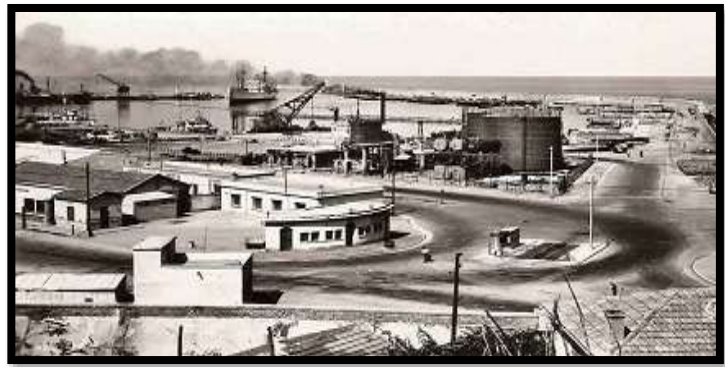
Figure 17: ancien port de Mostaganem
