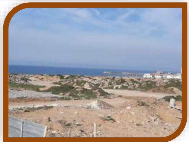
Figure 35: le cadre bâti industriel
