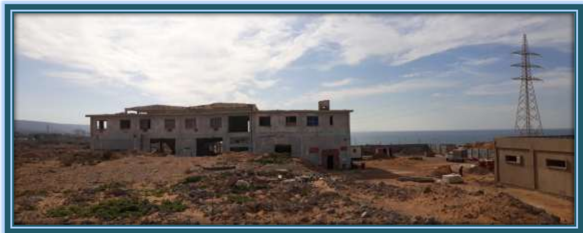
Figure 26: l'état actuel du terrain
