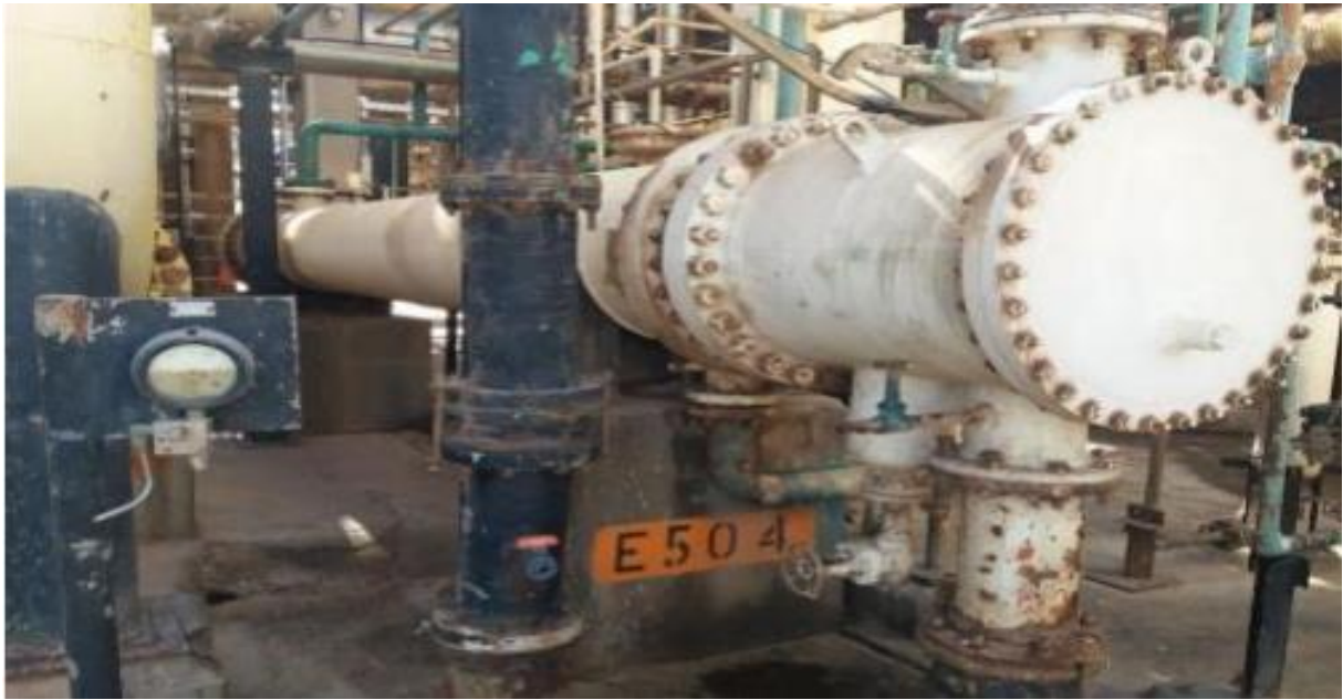
Figure I.2: Echangeur E-504 de la section de décarbonation.
