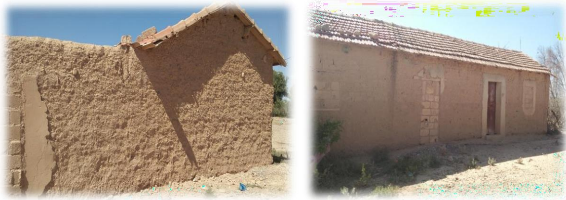
Figure II.16. Maison construit en terre de la ville Magra wilaya de M'sila [64].
