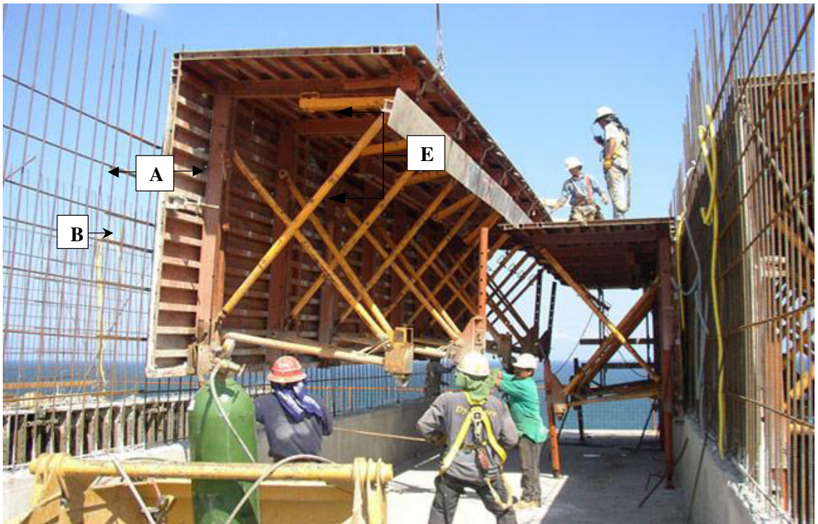
Fig I.4 : une demi-coquille sur chantier
