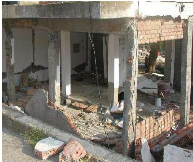
Photo 1 : Portique en béton armé endommagé séisme (21 mai 2003)
