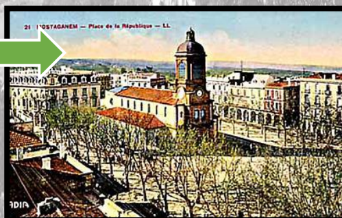
Figure 3- 8 / Vue Ancienne sur la place d'Arme.
