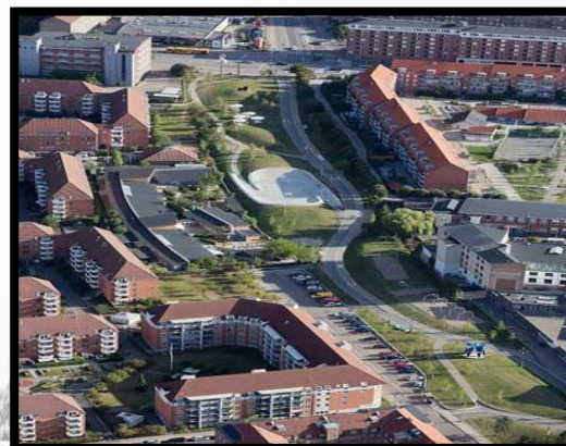
Figure 4- 36: le Green Park de parc superkilen URL : http://projets-architecte-urbanisme.fr
