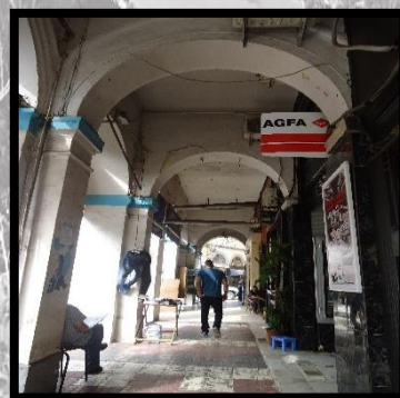
Figure 5- 24 : passage piétons au niveau de Rdc des arcades
