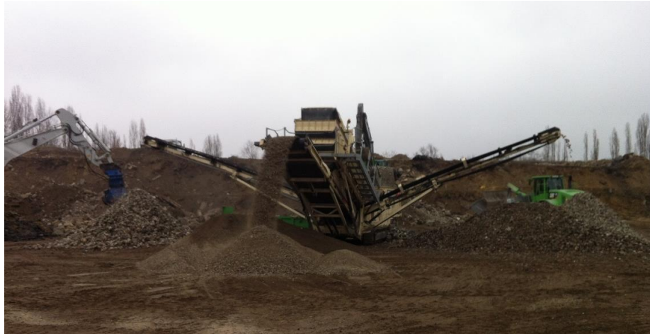
Figure I. 6 : Concassage des déchets de démolition (Centrale de tri Picheta dans le val d’Oise) [12]
