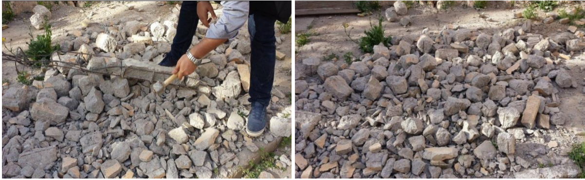
Figure II. 1 : La récupération des déchets de démolition des bétons.
