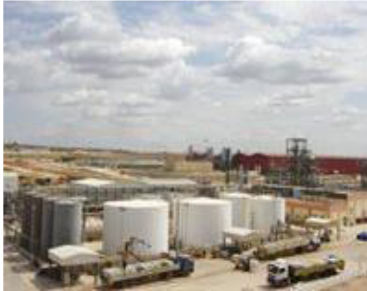
Figure I.4 : Usine de chlore (vue générale).
