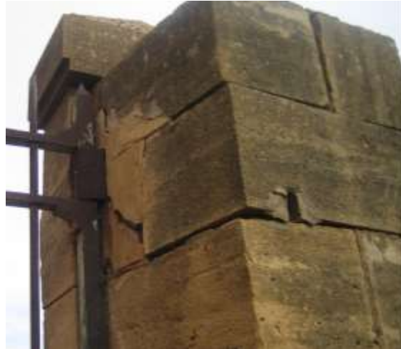
Figure 15 : dissolution du marbre
