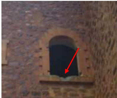
Figure 17 : épaufrure dans la fenêtre
