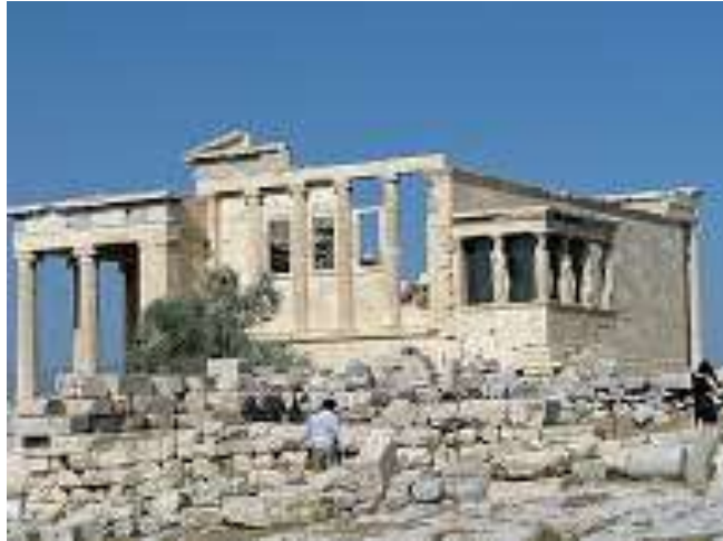
Figure 26 : L'Érechthéion après l'intervention de restauration
