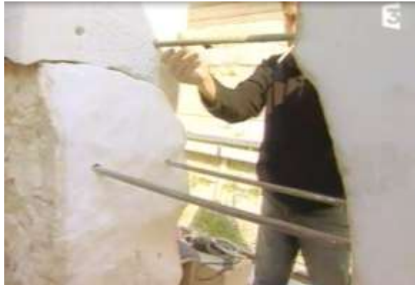
Figure 22 : Détail d'assemblage de l'ancien morceau de marbre et du nouveau de l'architrave
