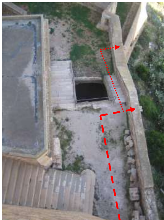
Figure 6 : Système d'évacuation des eaux pluviales
