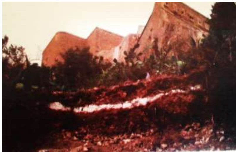
Figure 2 : Le four à chaux après le rasage. [10]
