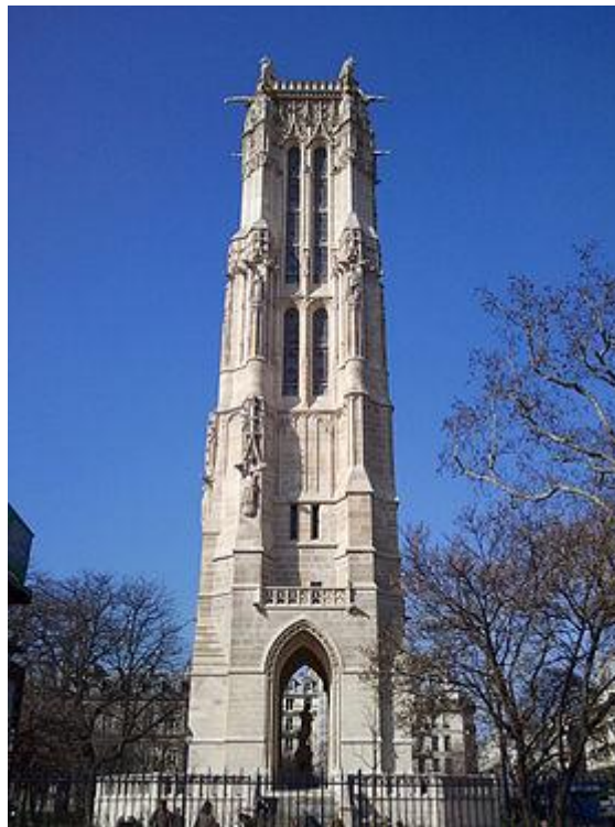
Figure6: Exemple de restauration à l'identique, Tour St-Jacques, Paris, dont le chantier de restauration de 2006 avait pour objectif restituer à l'identique les sculptures endommagées ou disparues
