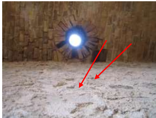
Figure 20 : pulvérisation des joints après la restauration
