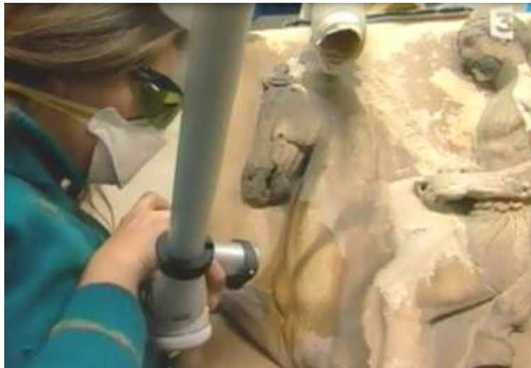
Figure 23 : Nettoyage au laser d'une frise
