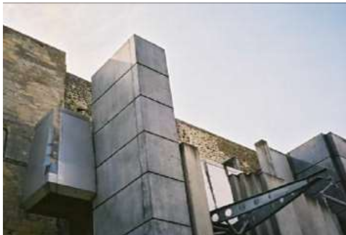
Figure 16 : Restauration de la Guérite et du pont levis on respectant le principe de réversibilité
