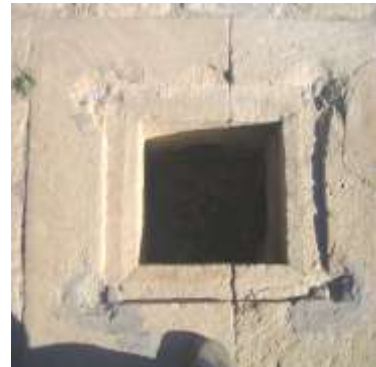
Figure 29 : Puits de collecte des eaux pluviales, source d'infiltration
