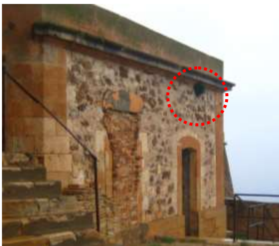
Figure 9 : Après la restauration des joints de maçonnerie de l'ajout français la végétation réapparaîtra de nouveau
