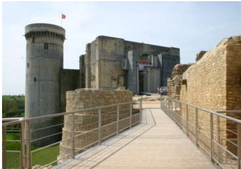
Figure 17 : La passerelle métallique du château après la restauration
