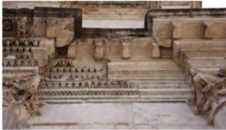
Figure 3 : section de droite restituée en travertin avec simplification des formes
