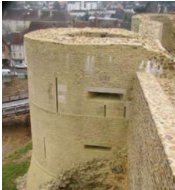
Figure 15 : Vue sur le donjon, les différents couleurs des mortiers
