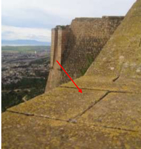
Figure 7 : Les Bryophyte (mousse) sur les parapets
