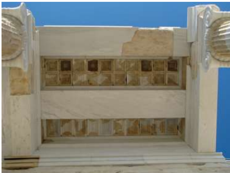
Figure 21 : Vue sur le plafond, les parties restaurées sont distinctes des anciens
