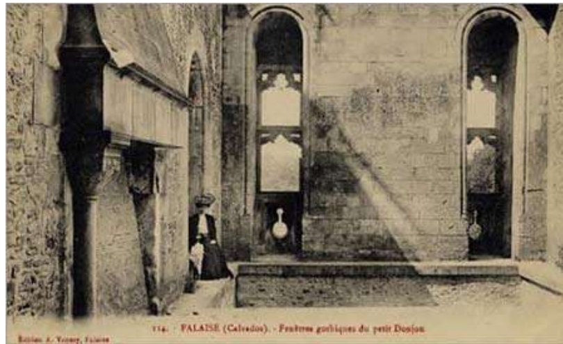
Figure 13 : Le petit donjon, les galeries aménagées remplacent les sols effondrés
