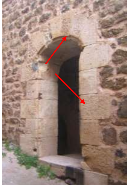
Figure 13 : Alvéolisation du marbre
