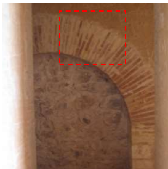
Figure 22 : L'arc après sa restauration Source : auteur du mémoire
