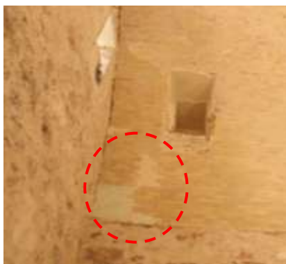
Figure 21 : La voute de la cuisine après sa restauration : Source : auteur du mémoire
