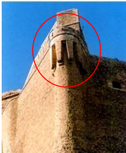
Figure 7 : Echauguette surplomb sur le rempart du château fort Santa Cruz.
