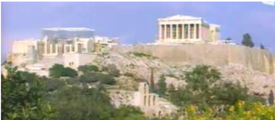
Figure 19 : Vue générale sur l'acropole d'Athènes
