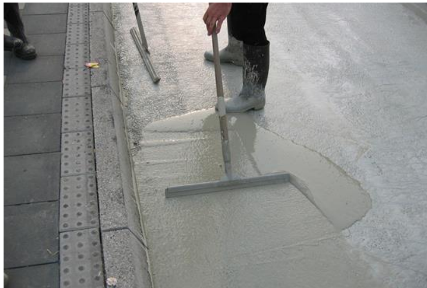
Figure I.1.1: Coulis d'ancrage et d'injection [3]
