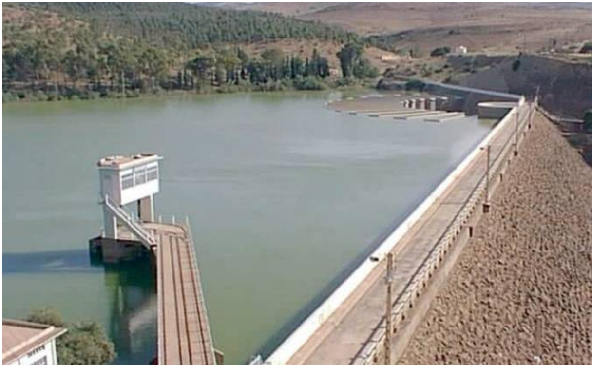
Figure 6 : Barrage en Algérie (56)
