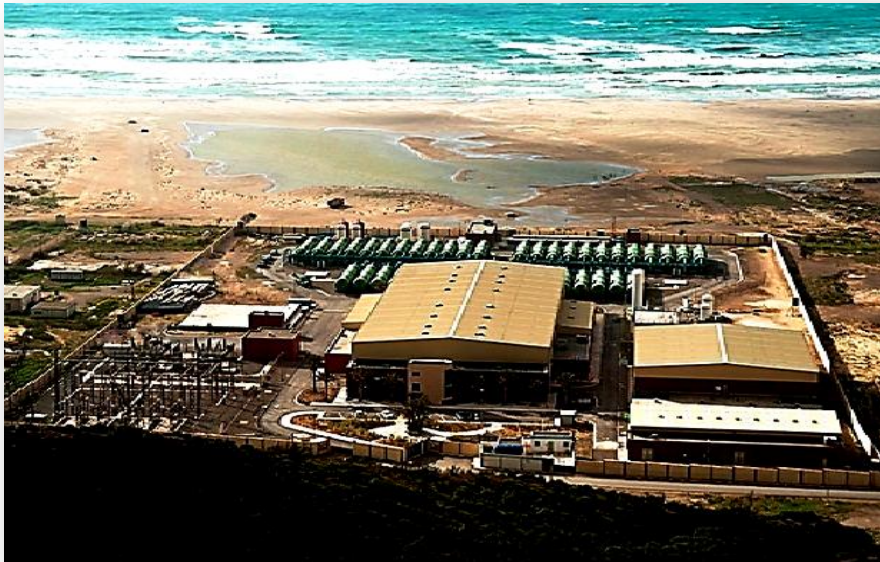
Figure III-1: Station de dessalement de l'eau de mer de Mostaganem
