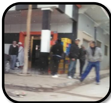
Figure 22: Déradation des trottoirs.
