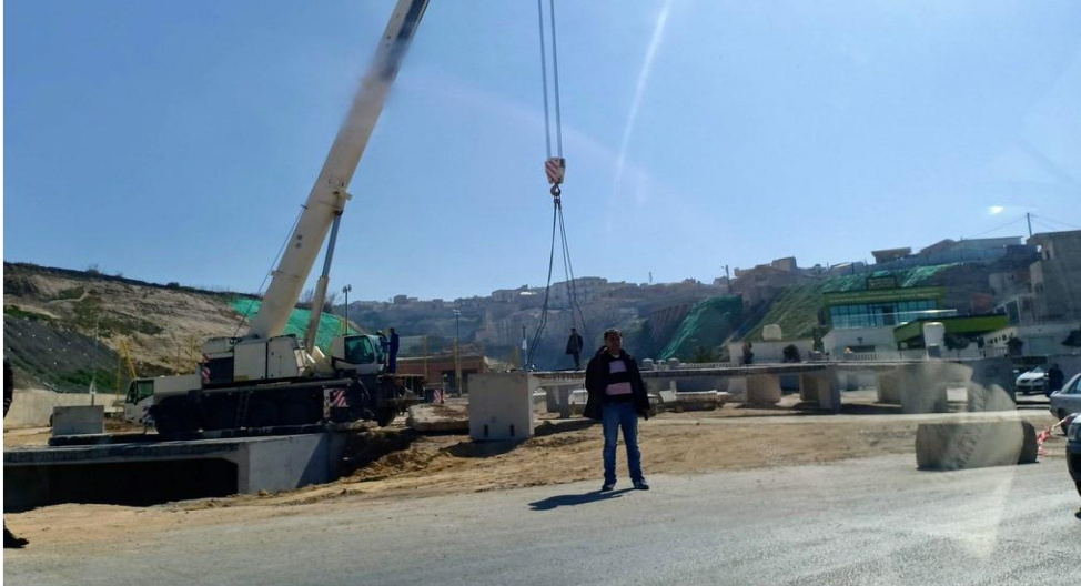
Figure II.21 : réalisation d'ouvrage dalot.
