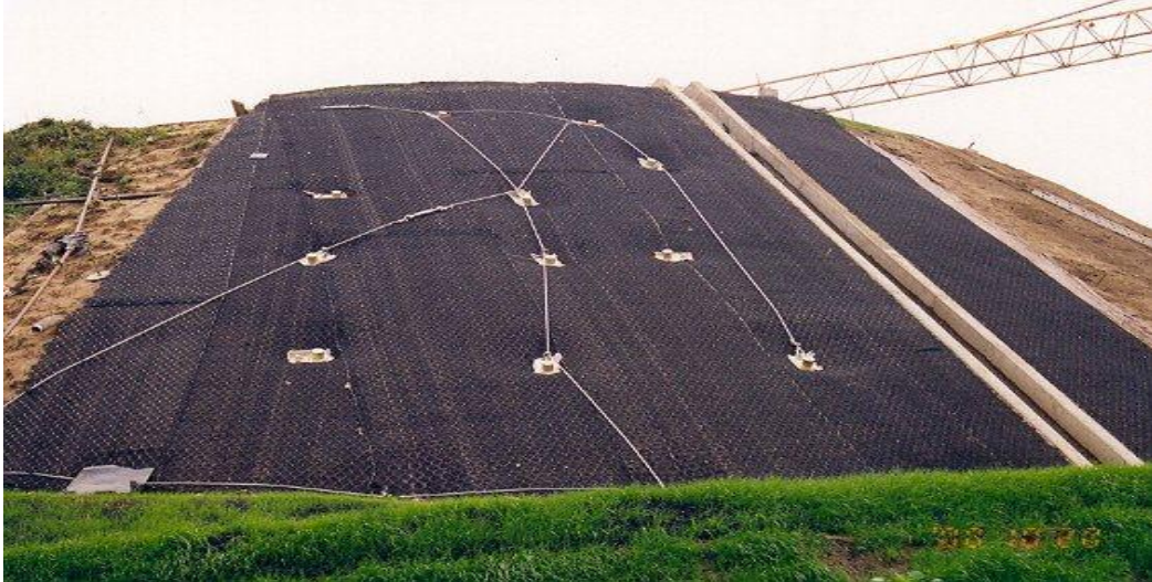
Figure II.16 : Le système geogrid végétalisé.
