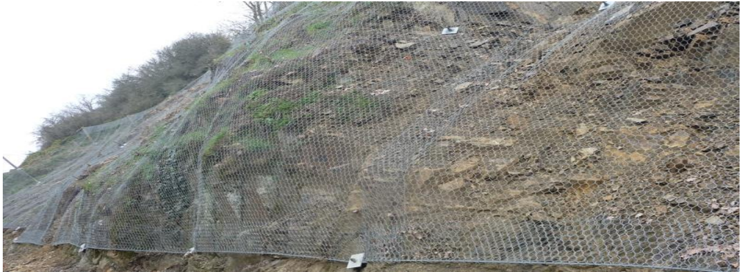
Figure II.18: Grillage plaqué par des tiges d'ancrage.
