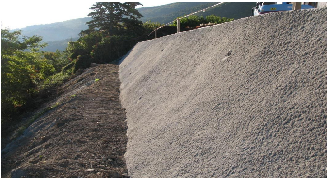
FigureII.17 : Le béton projeté sur le talus.
