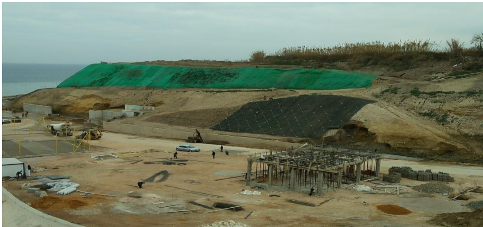
Figure II.19 : les murs de soutènement en béton armé.
