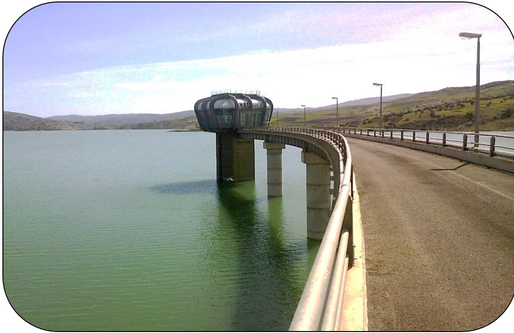
Figure 5: barrage de Kramis (willaya de Mostaganem).
