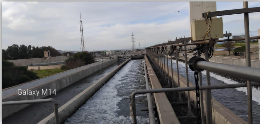
Figure I-4. Dessablage et Déshuilage.
