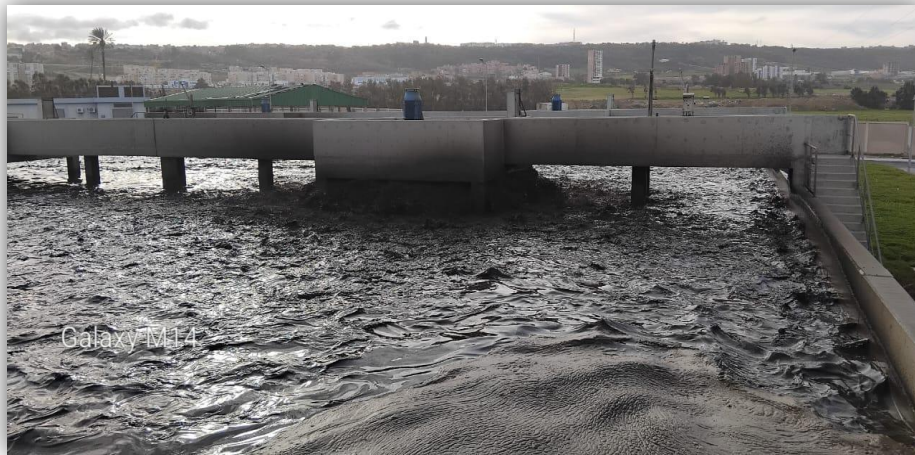
Figure I-10. Bassin de stabilisation.
