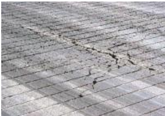
Figure II.14 : Faïencage avec un niveau de gravité léger
