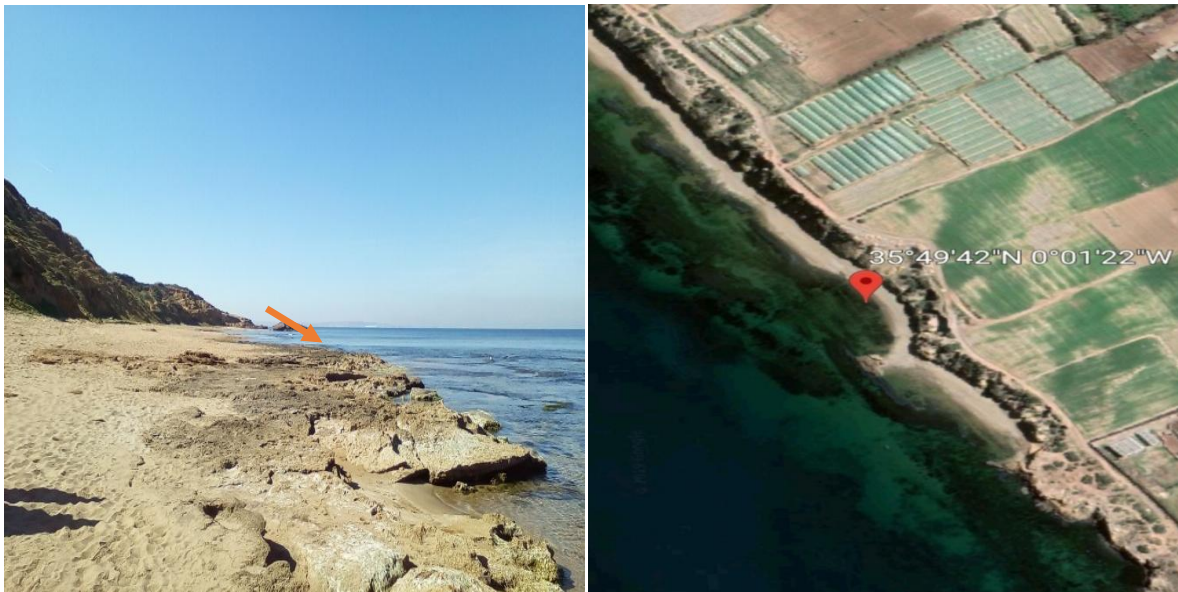
Figure23 : vue général sur le site de stidia
