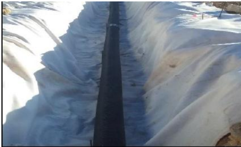
Photos : Réalisation du drainage profond
