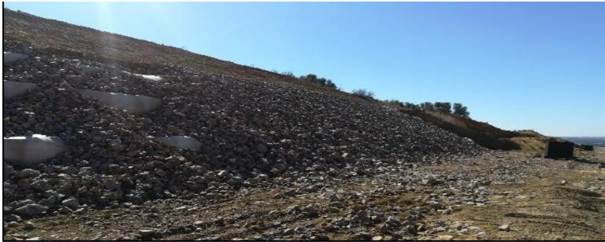
Photos : Reprofilage des talus dégradés (1er talus), et réalisation des redans réguliers de dimension 1.5V/2H
