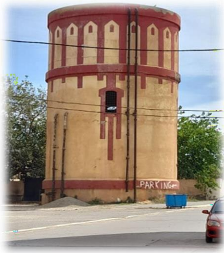
Photo21 : r éservoir d'eau
