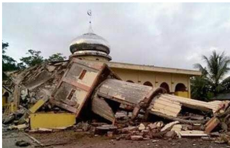
Figure1.14 : Effondrement total du mosque
