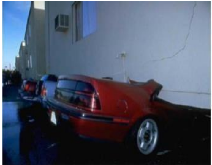
Figure 1.19: Cisaillement de l'étage souple.
