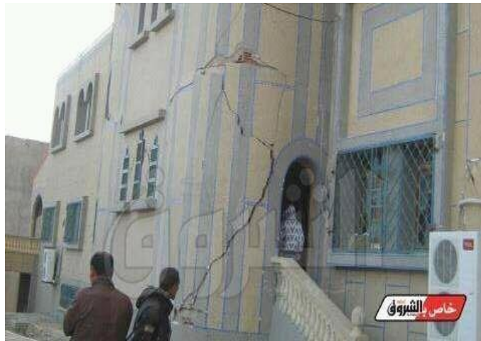
Figure 1.17. Effondrement de la maçonnerie
