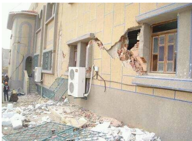
Figure 1.17. Effondrement de la maçonnerie
