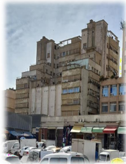
Photo17 : Bâtiment colisé (B3)
