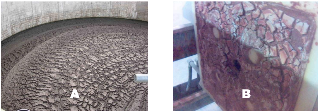
Figure 1.2 : Boues d'épuration : A , stockées en silo. B , Plaque de boues déshydratées à l'ouverture de filtre-presses [3]
