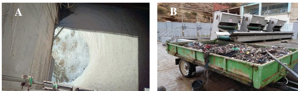
Figure 2.4 : A Vue sur un grillage grossier B Vue sur trois éléments de grillage fin
