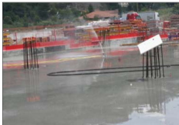
Figure II.8. Exemple de cure par aspersion d'eau en surface d'une dalle coulée en été [5].
