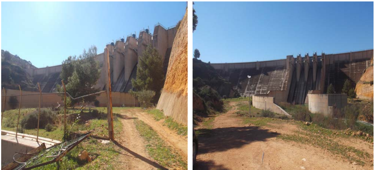
Figure IV.15. Vue générale du barrage Chorfa II
