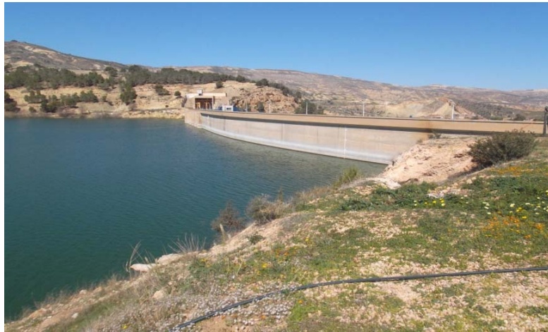
Figure IV.17. Vue du côté interne de la digue du barrage Chorfa II
