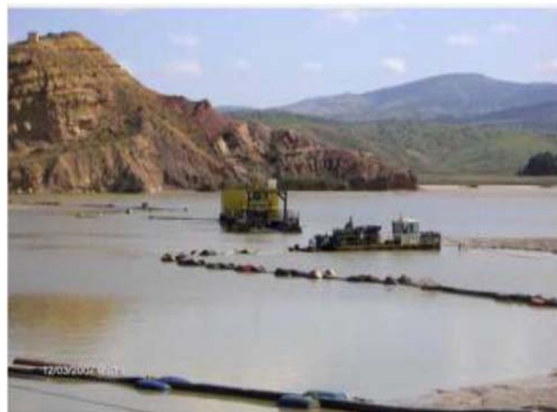
Figure IV.2. Opération de dragage du barrage de Fergoug en 2007[17]
