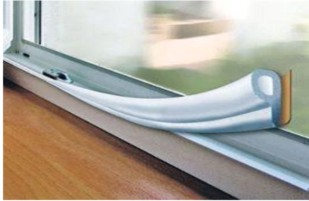
Figure2-13:Etanchéité pou fenêtre (joint gonflables ).
